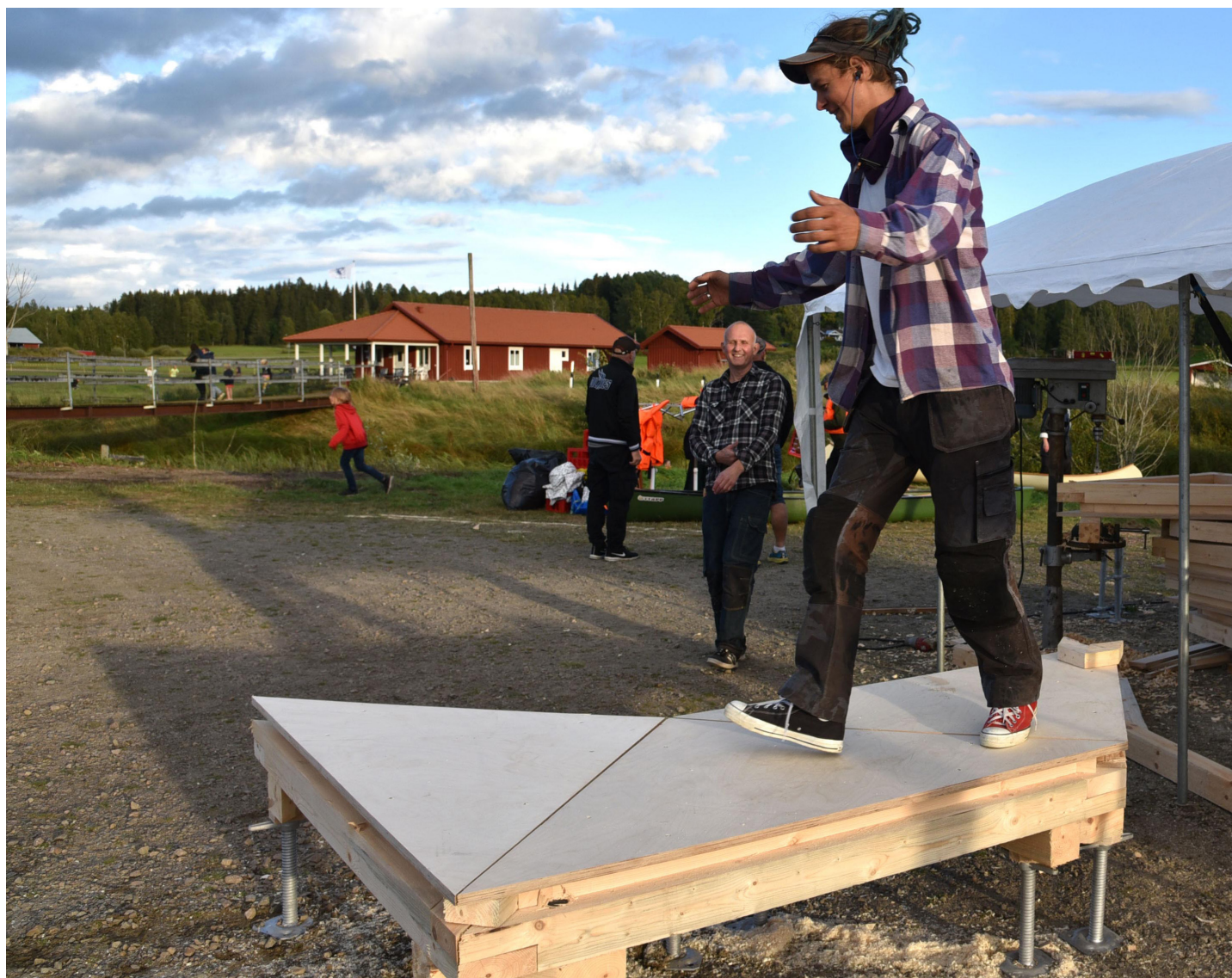
Dansbanan - modulär och flyttbar. Här under konstruktion 5 sept 2020, Foto Kjell Sundström, KM IDÉ
